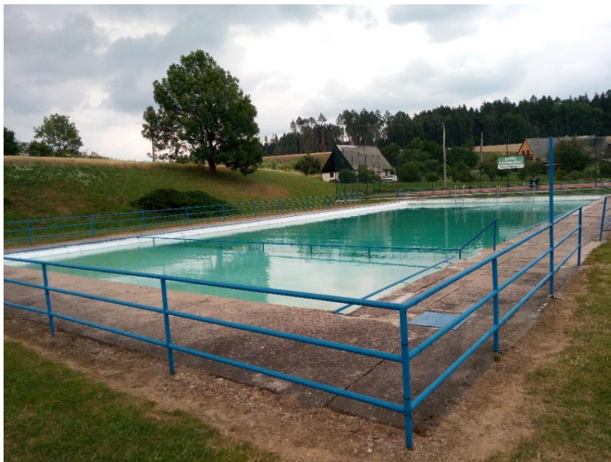
Obrázek 3: Požární nádrž v obci Mezilečí
