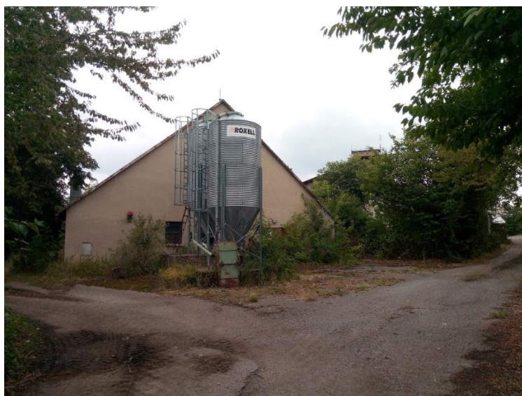
Obrázek 6: Chátrající areál bývalé odchovny selat v obci Mezilečí – pohled od vstupní brány do areálu (stav k červenci 2018)
